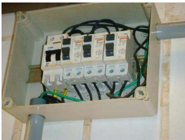
Figura 4.22 - Dispositivo DR - diferencial residual. Fonte: arquivo pessoal, 2012.
